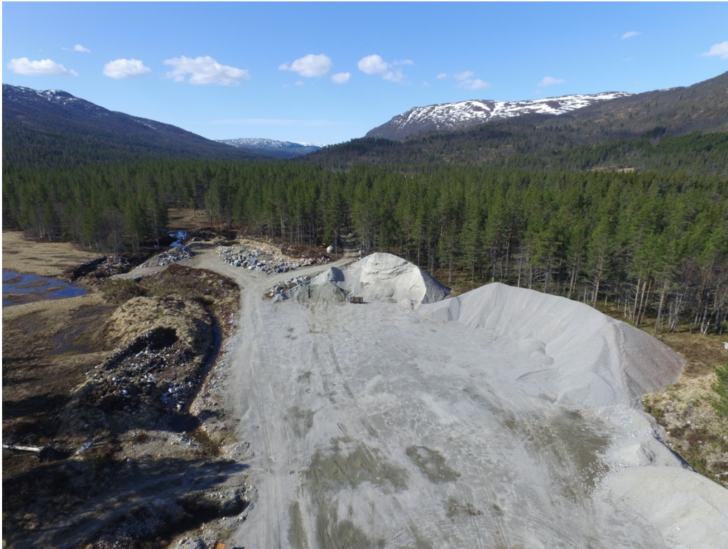
Bilde frå 16.5.2019 sett mot sør. Viser lagring av massar og vegen som går ned til uttaket av elvegrus.
