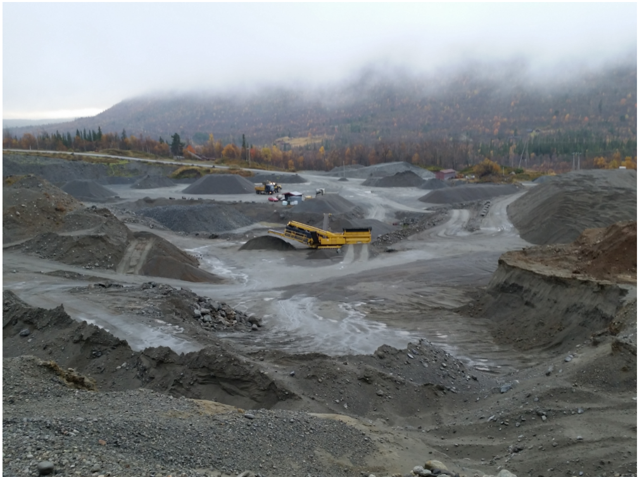
Skredbergo massetak sett fra nord – november 2015
