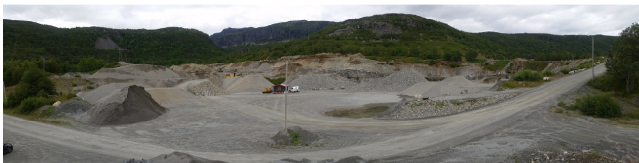
Uttaksområdet sett i forhold til Fv288 og eksisterende bebyggelse – bilde fra august 2017
