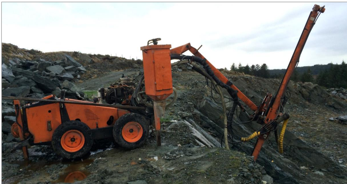
Figur 4. Uttak av steinblokker ved hjelp av borerigg.
