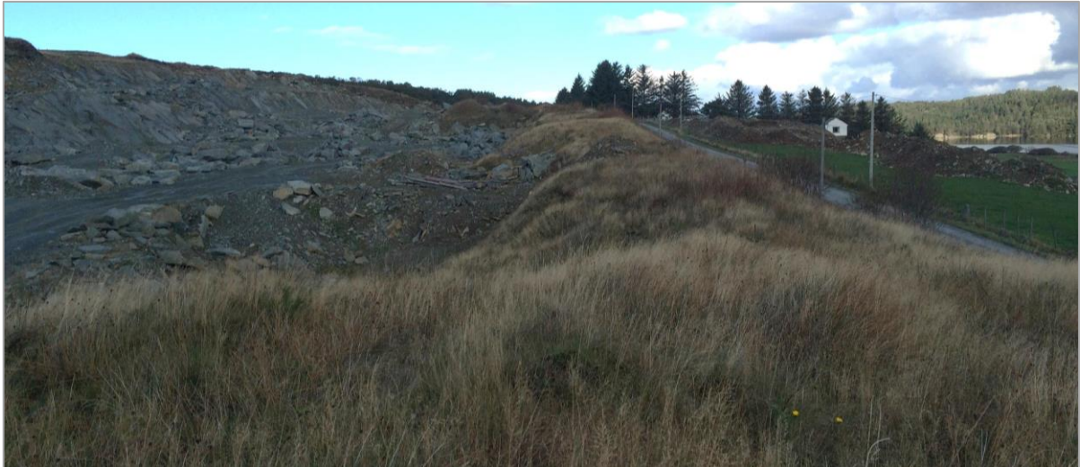
Figur 7. Støyvoller mot Skjenavegen.
