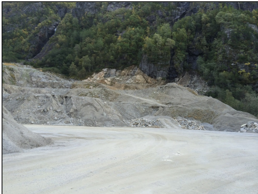
Bilde 9: Det ses hvordan massene øverst er fjernet helt inn til fjellveggen. Dessuten ses pallene samt den etablerte anleggsvei opp i uttaket.
