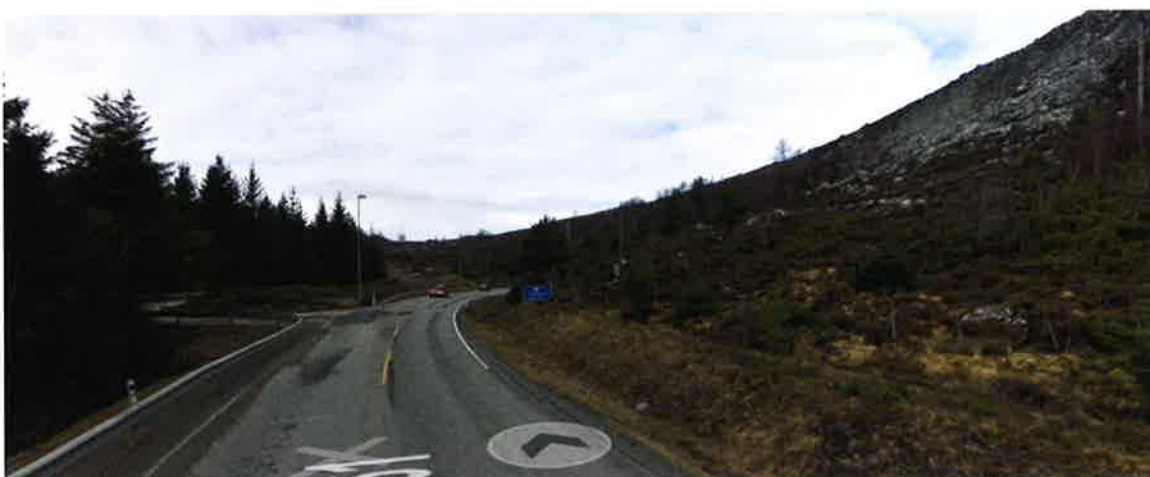
Foto fra tilkomsten masseuttaket sett fra sør mot tunnelåpning
