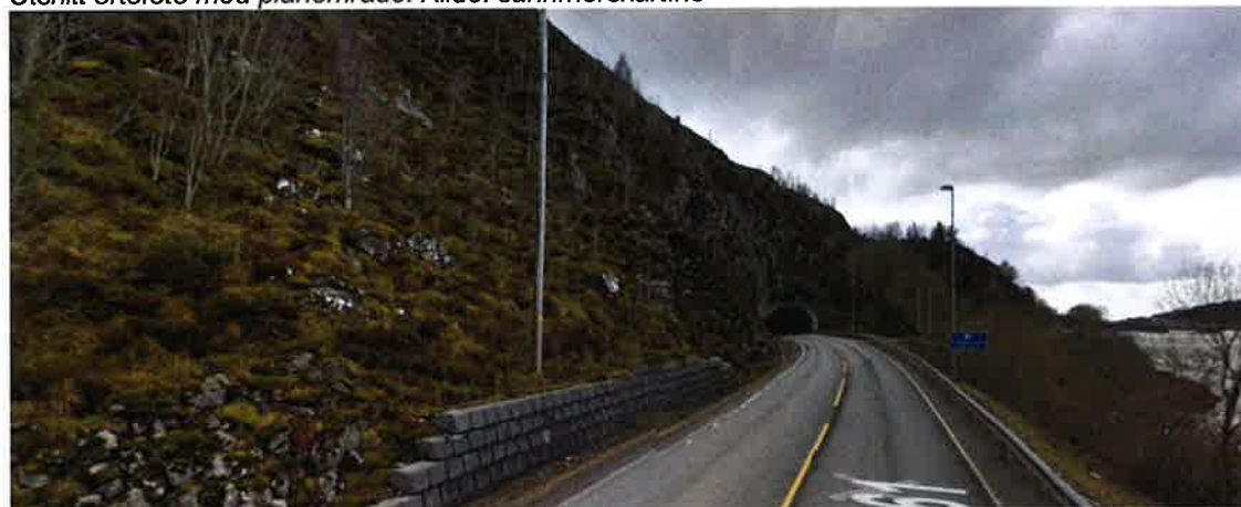
Foto mot tunnelåpning ved fylkesvei fra nord
