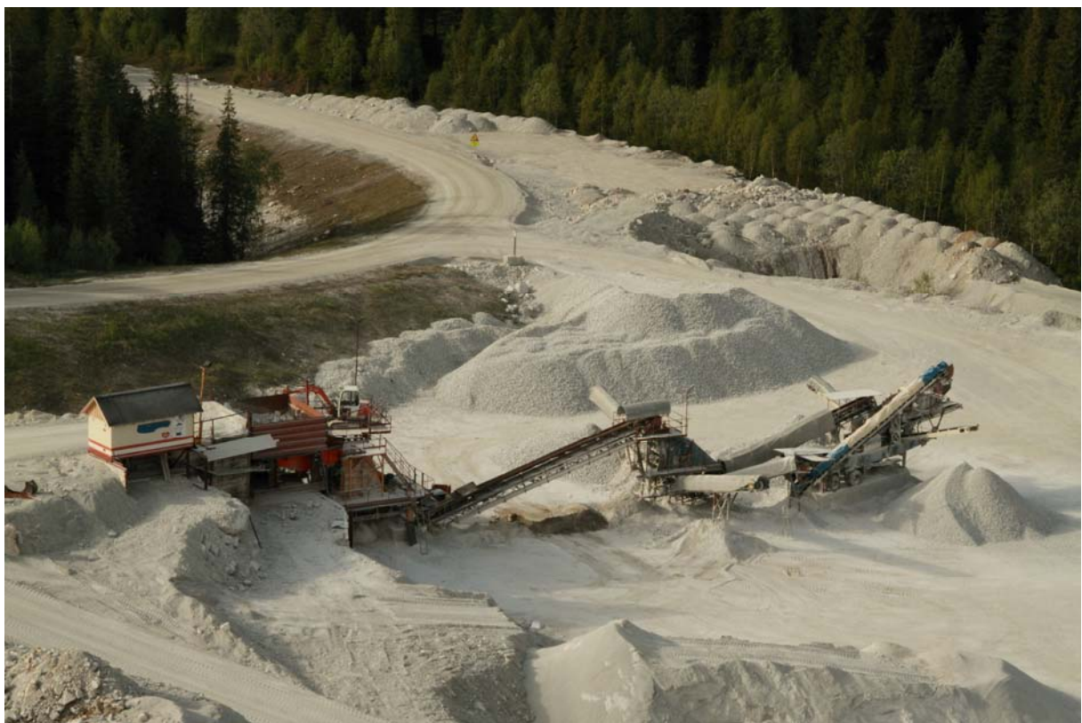
Figur 4: Dagens brudd sett fra sør
