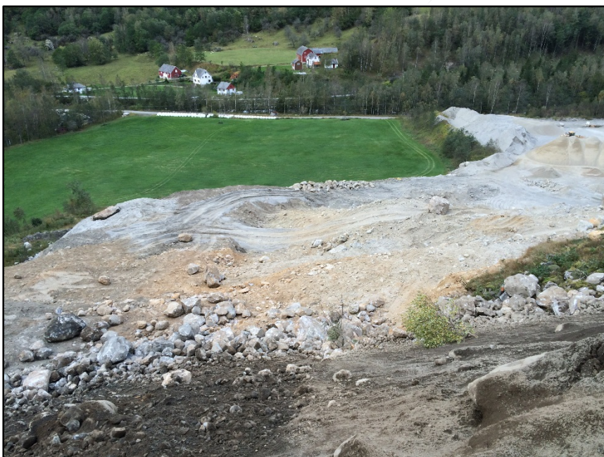
Bilde 13: Bilde tatt nedover uttaksområdet fra øverste pall. Det ses at det er etablert anleggsvei opp til pallene også fra denne siden.
