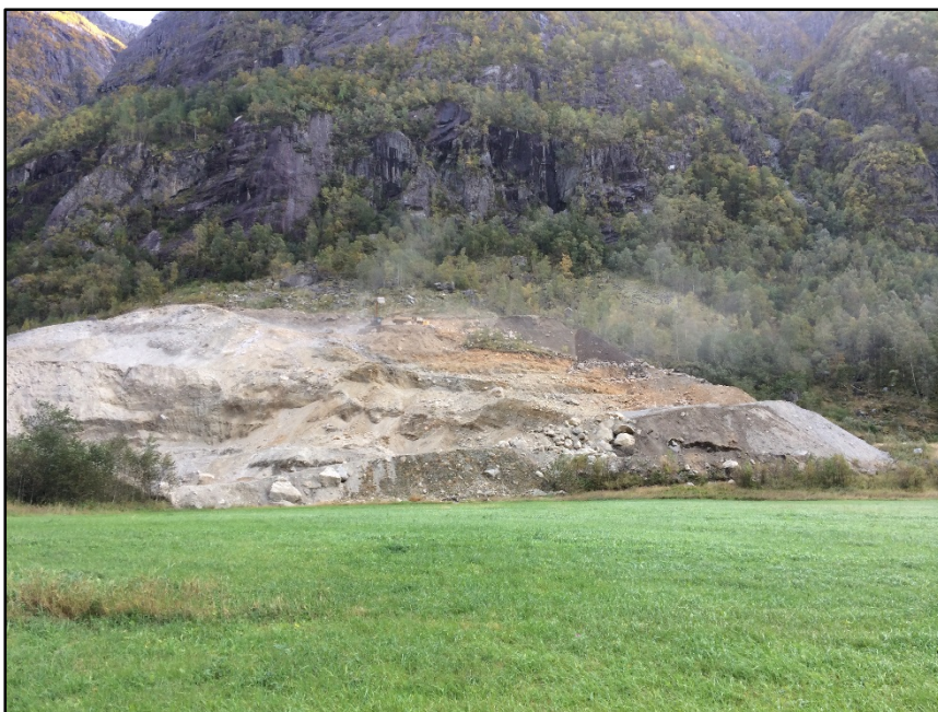
Bilde 14: Uttaket på Fiveland sett nedenfra. Løs massene er en stor kontrast til det massive fjell som ligger bak.
