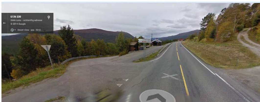
Figur 1. Avkjørsel fra E136 til Lordalen. Kilde: Google Street View.
