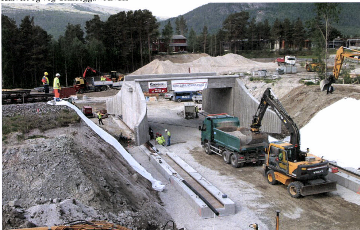
Kulvert og veg Grindegga - Alvdal
