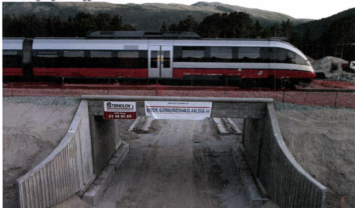
Kulvert og veg Grindegga - Alvdal
