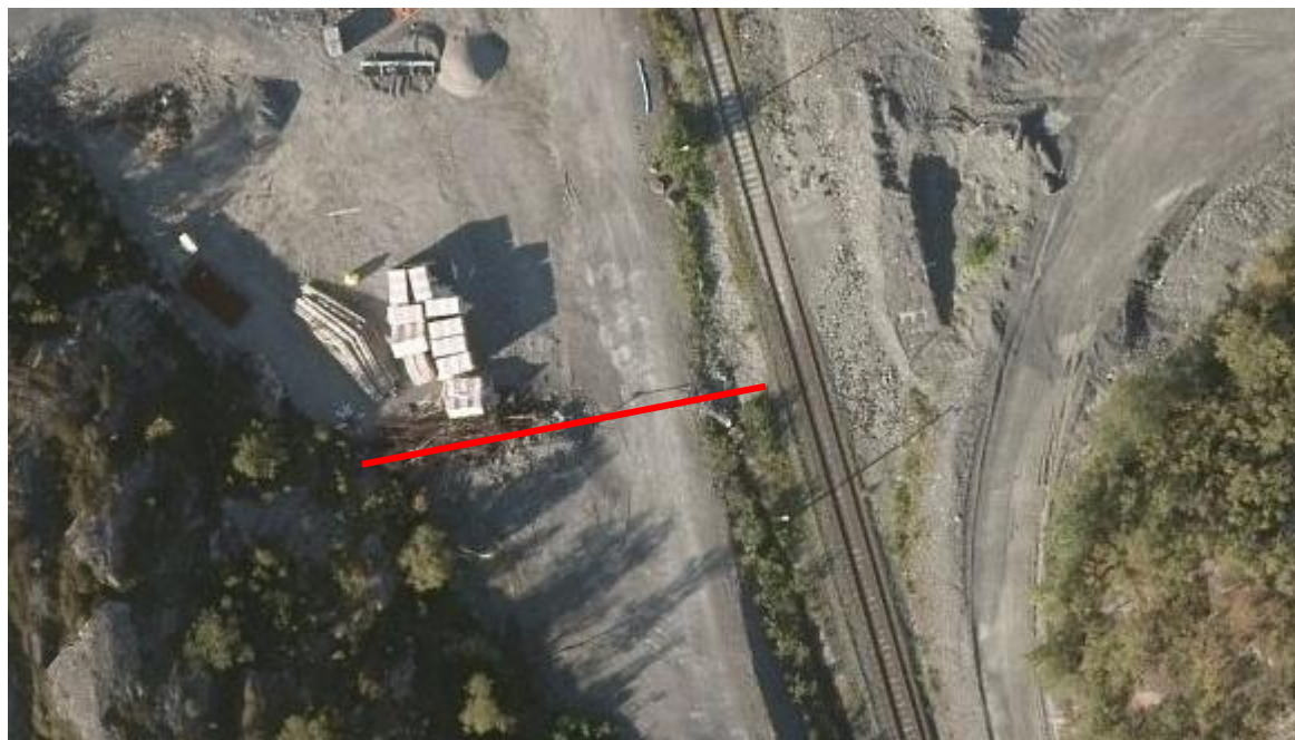
Figur 5 Oversiktsbilde - Adkomst via BMT
