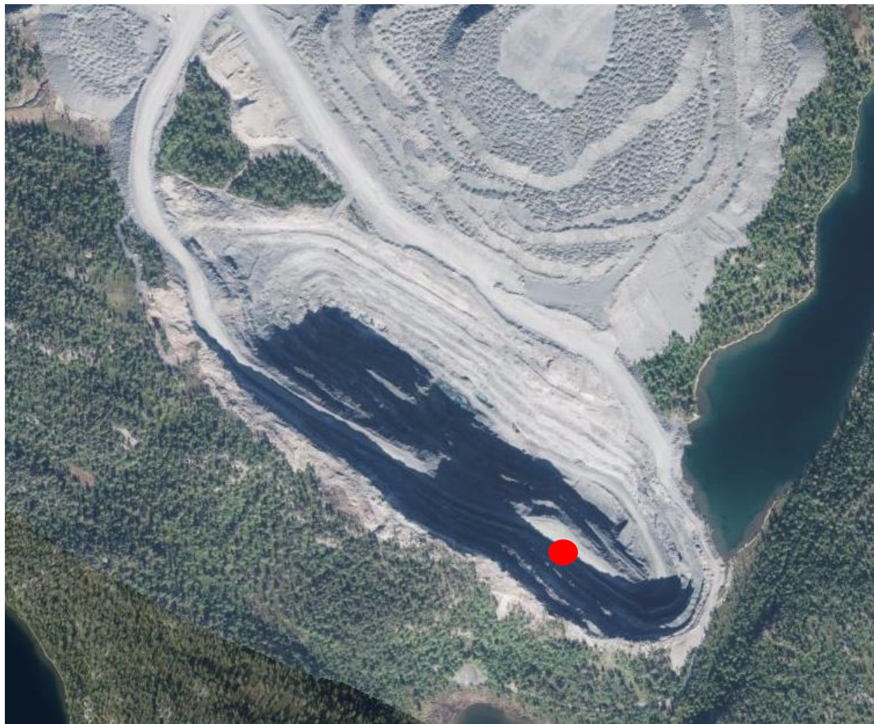
Figur 38 Oversiktsbilde - Kjellmannsåsen, inngang dreneringsstoll i brudd
