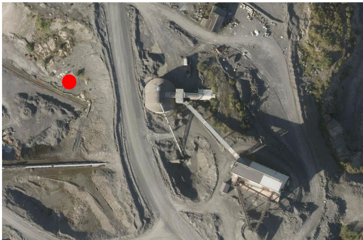
Figur 46 Oversiktsbilde - Tappetunell pukksilo
