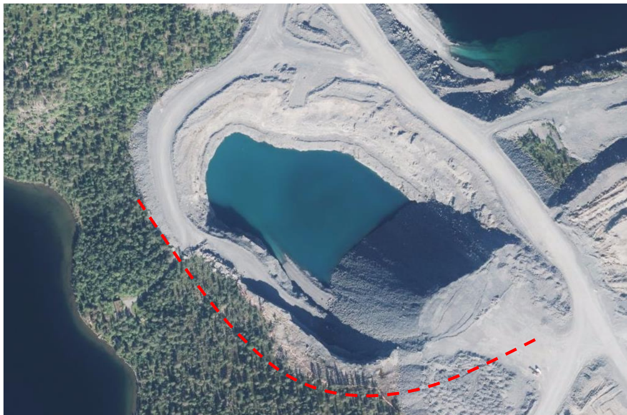
Figur 36 Oversiktsbilde - Hyttemalmen Dagbruddskant
