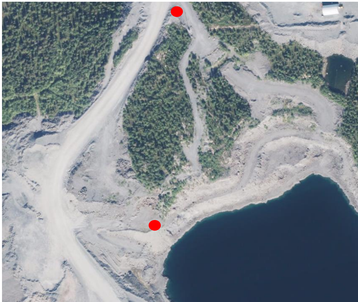
Figur 35 Oversiktsbilde - Jerntoppen, FBT-tunell
