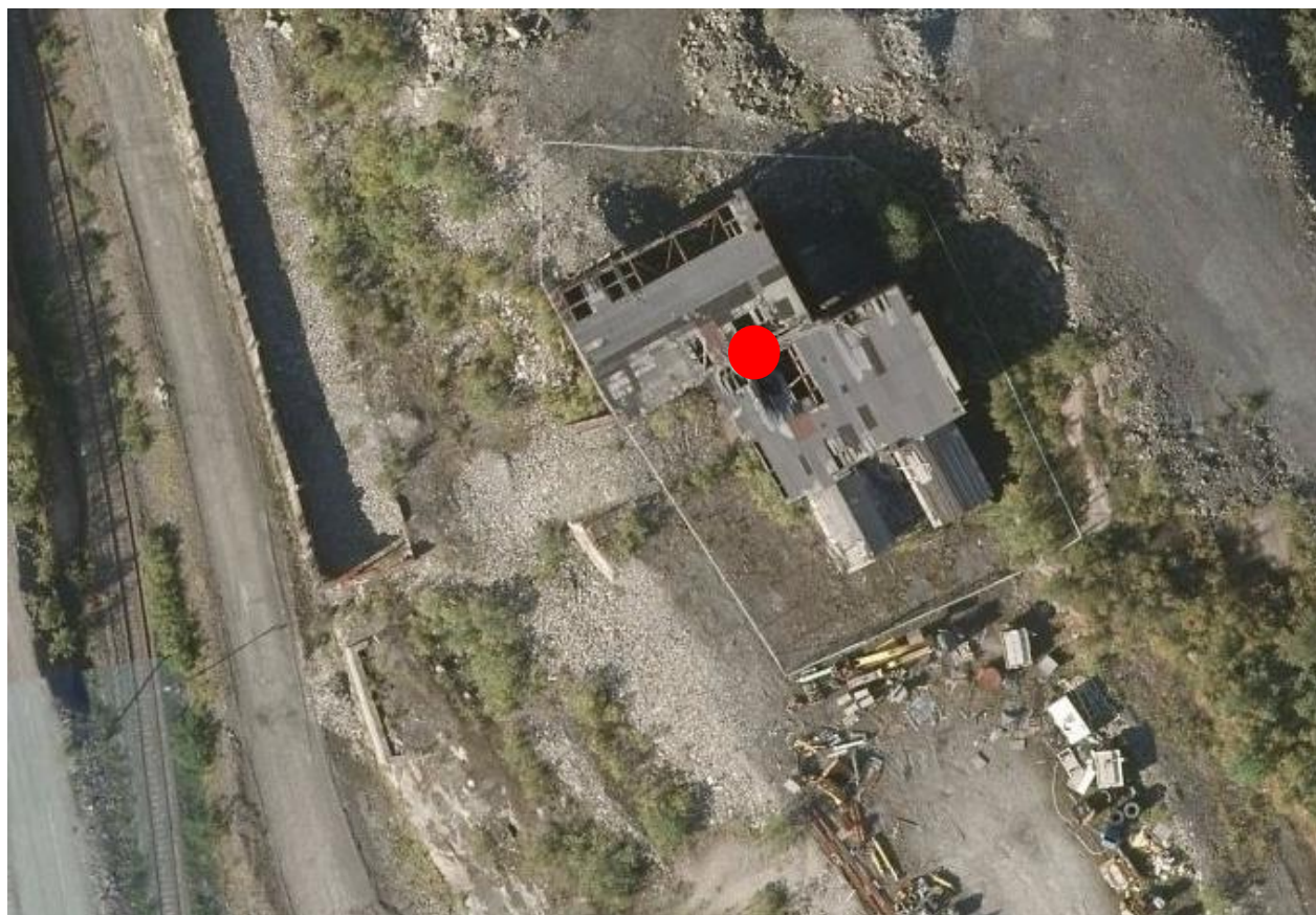
Figur 49 Oversiktsbilde - Gamle knuserverk
