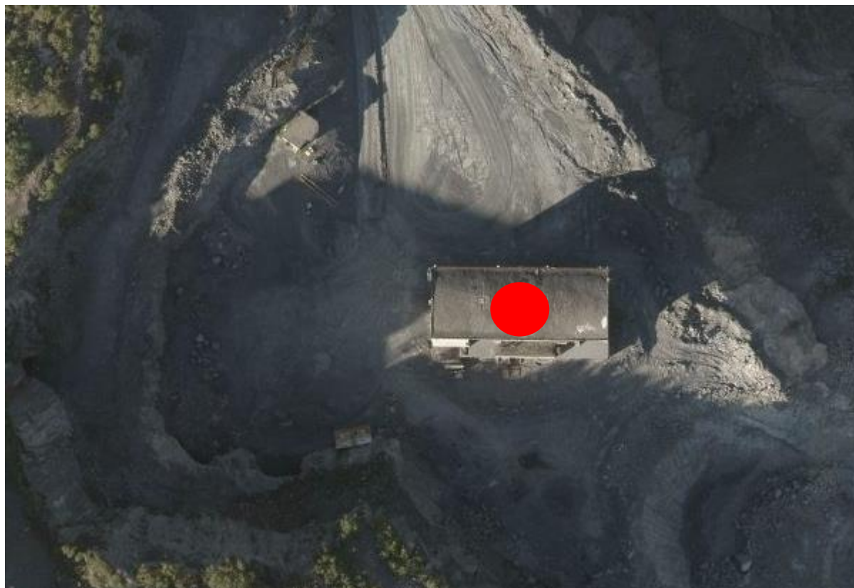
Figur 45 Oversiktsbilde - Knusergrop, silo og heis
