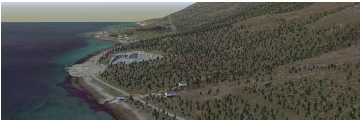
Over: oversiktsbilde mot vest. Dagens situasjon.
