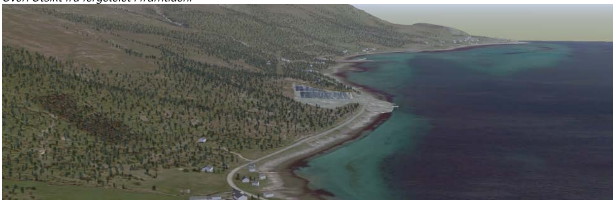
Over: Oversiktsbilde mot øst. Dagens situasjon.
