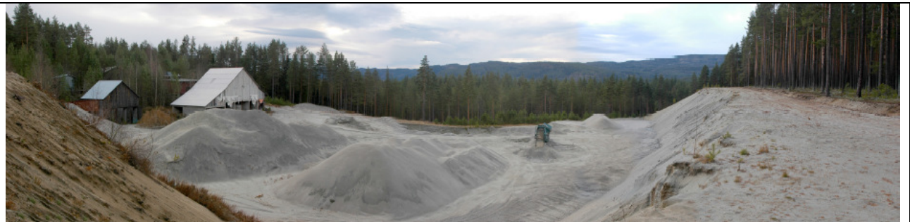
Fig. 9. Eksisterende brudd og bruddfront sett mot sør. (COWI 2008a)
