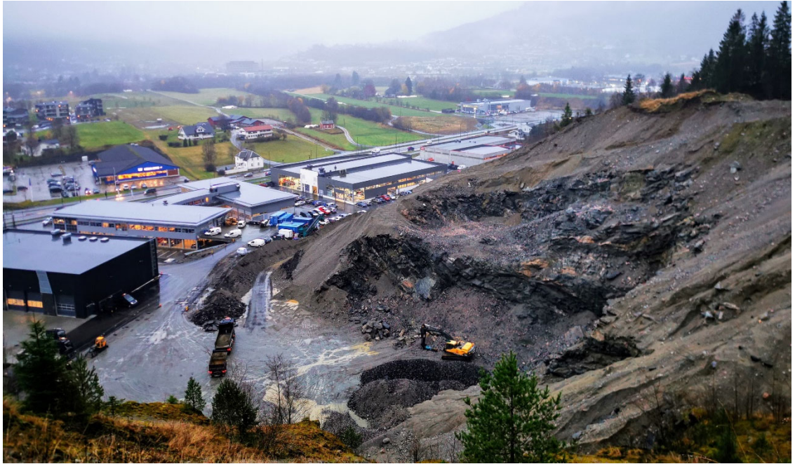
Foto teke i retning nordaust. Viser framkanten av uttaket som går i austleg retning. Dato: 05.11.2020.
