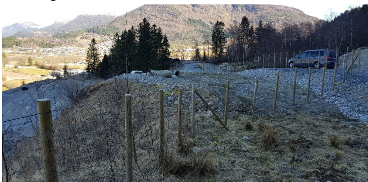
Foto teke av sikringsgjerde i sør.
