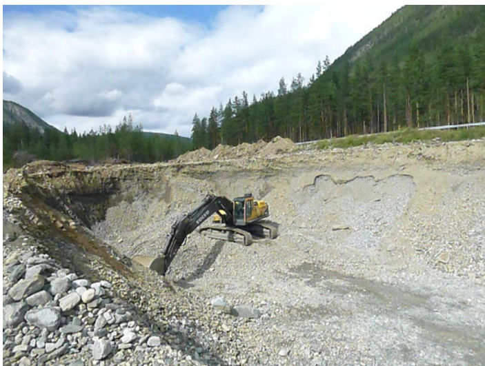
Figur 5: Uttak av usortert masse som foregår innenfor etappe 1 viser at det er gode og høye bruddkanter med tanke på støyskjerming.
