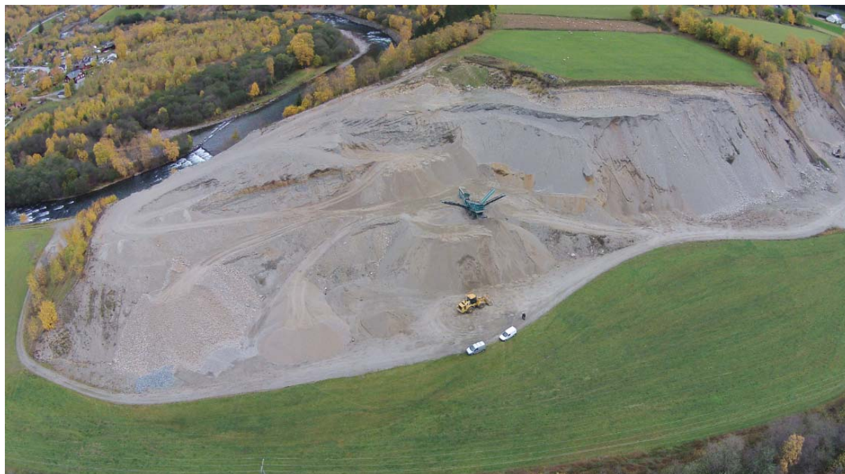
Bilde 6. Dagens situasjon(oktober 2014).
