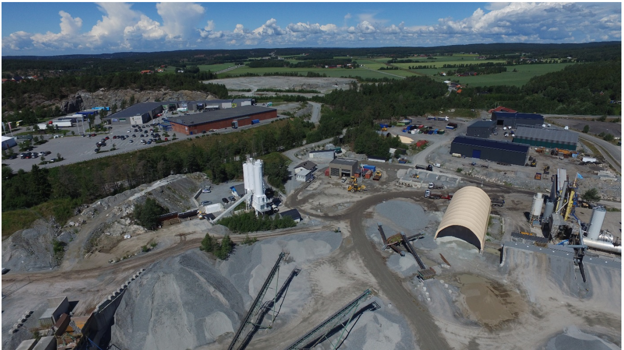
Drift-og lagerområde. Til venstre: NorBetong -betongstasjon, til høyre: Skanska -asfaltstasjon. (foto juli 2016)
