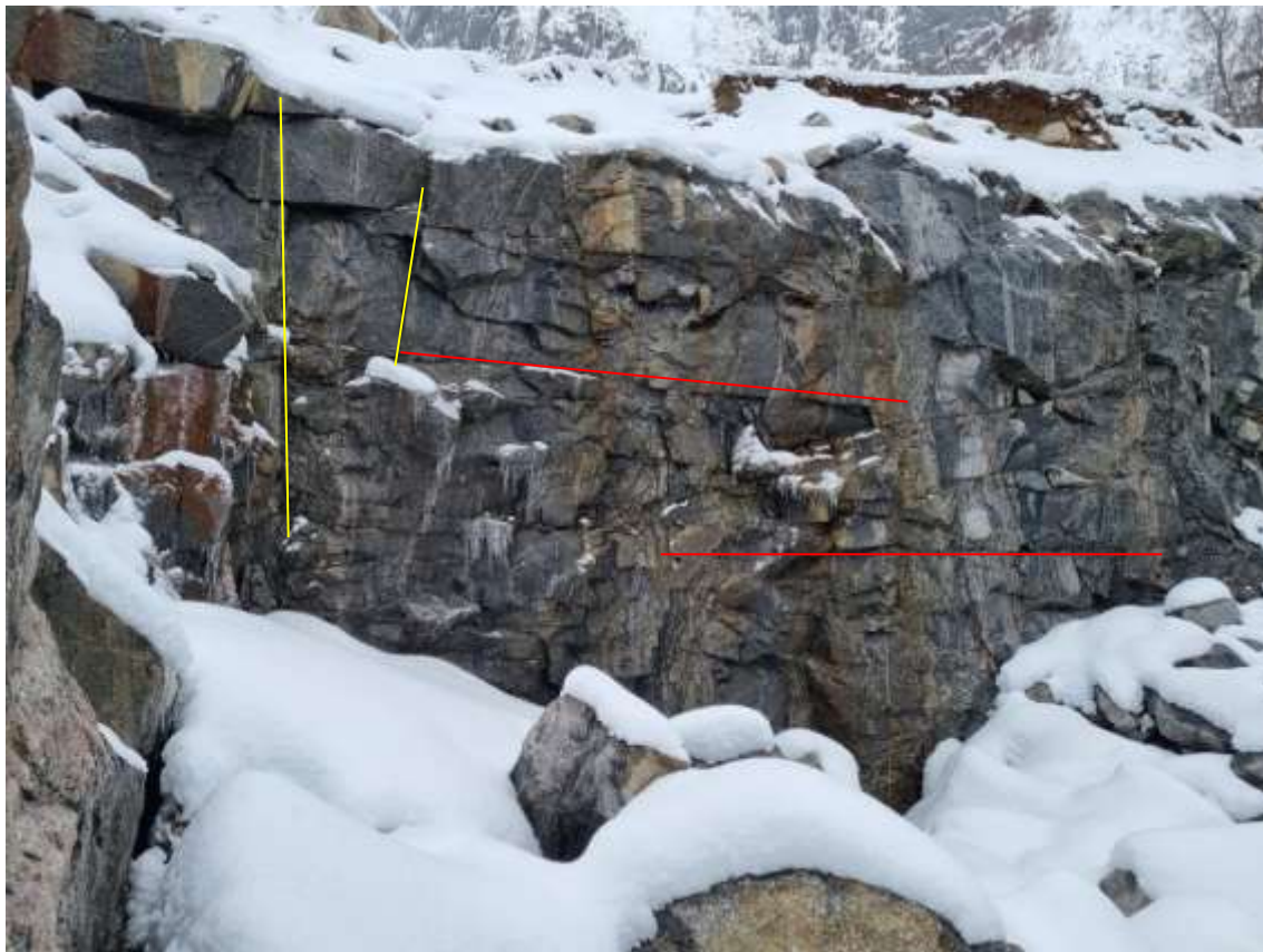
Figur 2. Registrerte sprekkesett. S1 markert med rødt, og S2 markert med gult
