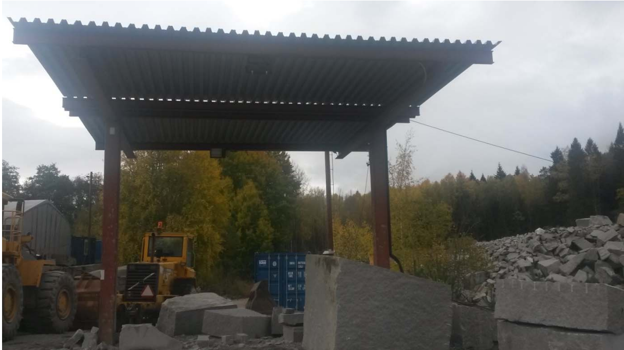
Figur 6. Fra riggplass: emner som deles til ferdige produkter ved boring og kiling.
