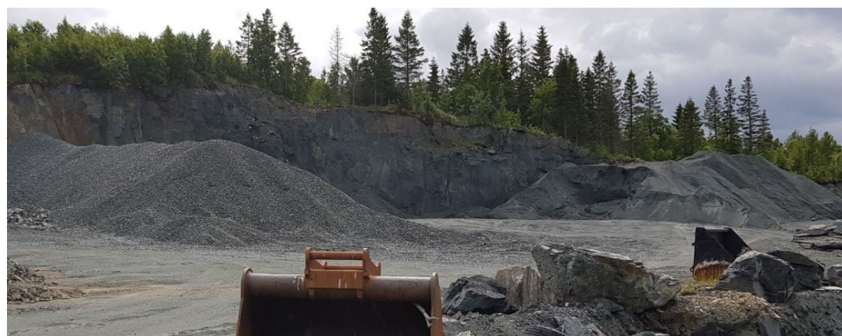
Fig.12: Bruddvegg mot øst og fylkesvegen følger vertikal lagdeling som gir en ryddig overflate.
