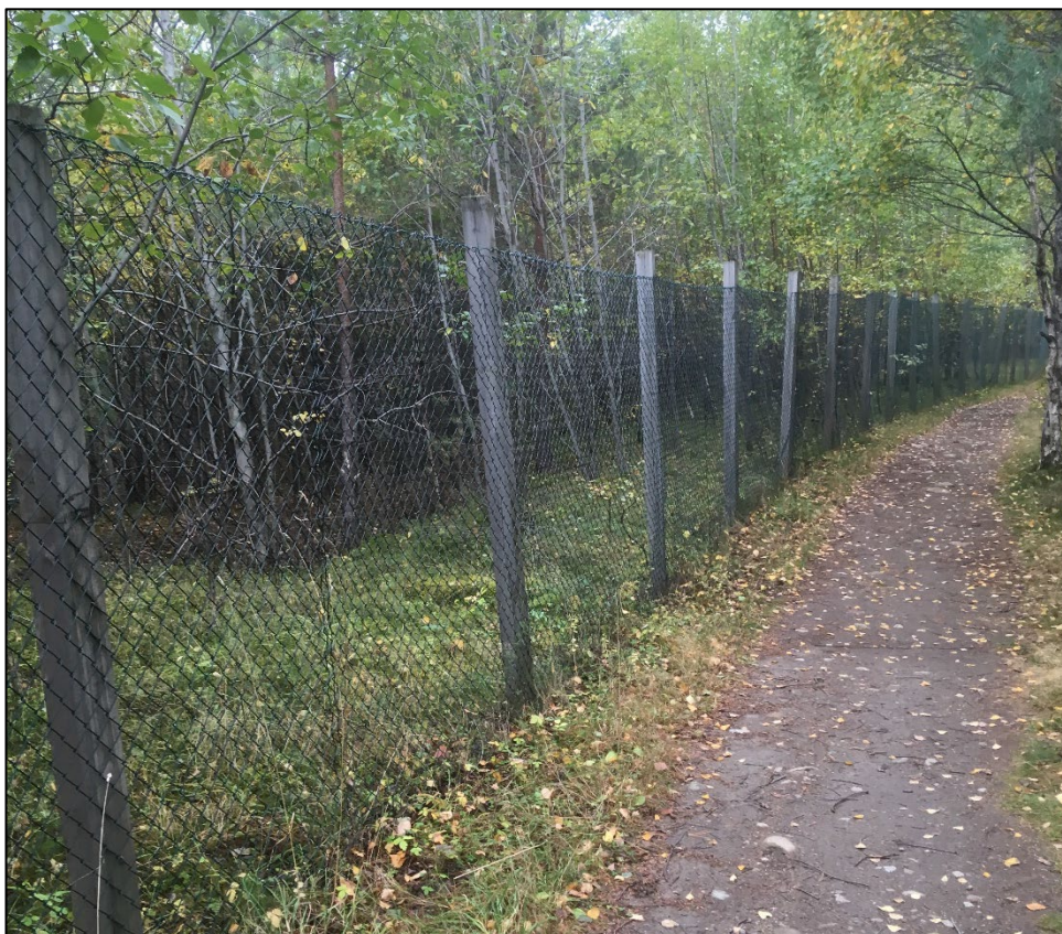
Figur 2-2. Området er allerede i dag inngjerdet og sikret – her bilde av gjerde mot nord. Tilsvarende gjerde er satt opp rundt hele tiltaksområdet.
