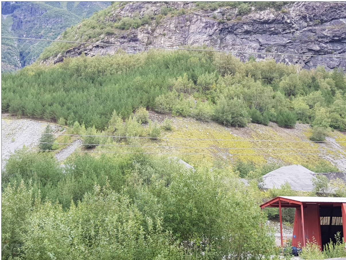
Figur 1-4. Deler av grustaket er allerede istandsatt og skal ikke gjøres noe med. Skråning som vises i høyre halvdel av bildet er avsluttet og arrondert.
