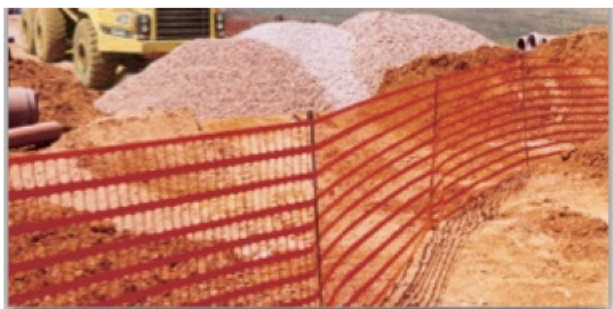
Figur 10. Eksempel på midlertidig gjerde. Høyde 1 meter.
