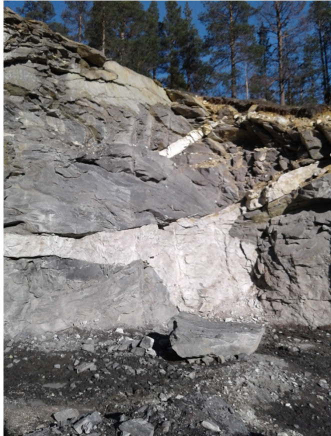
Figur 6. Bruddvegg viser lysere partier i materialet. Bildet er tatt av Norconsult 6.10.2016.
