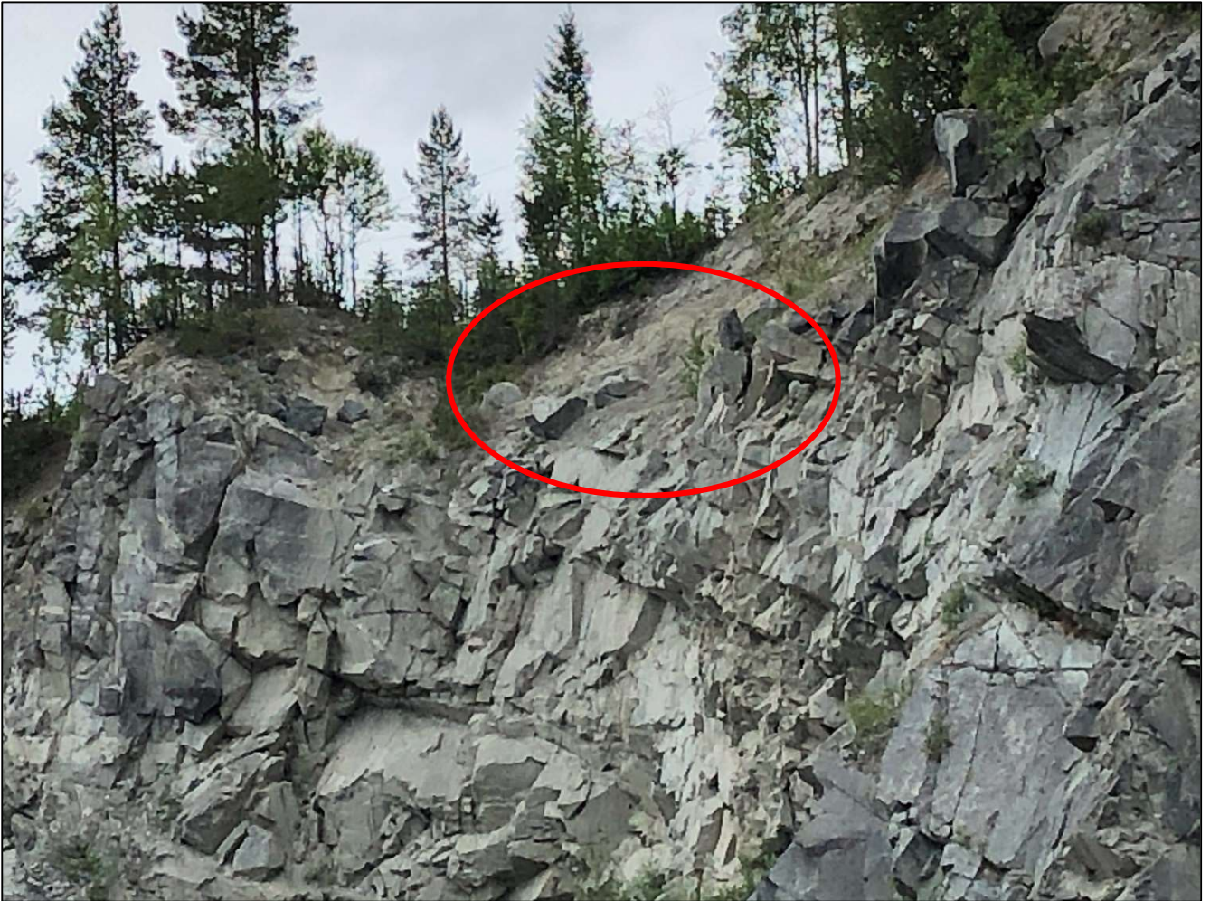
Figur 6. Eksempel på ustabile blokker på skjæringskanten
