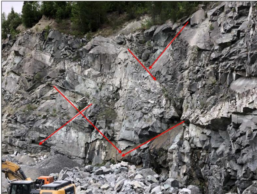
Figur 2: Østre bruddvegg der gjennomgående sprekker er markert med rødt som kan danne kiler for utgliding. Ref: vedlegg 1, figur 4.
