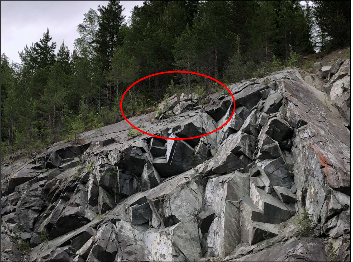
Figur 5. Eksempel på ustabile blokker på skjæringskanten
