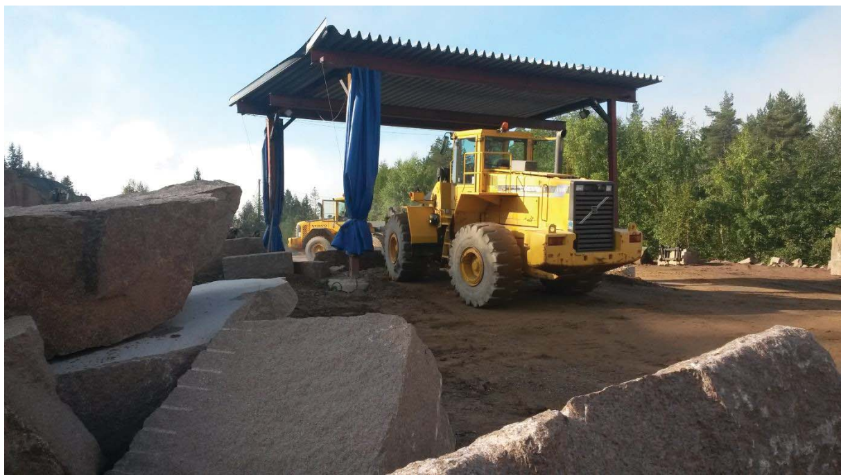
Figur 6. Fra riggplass: emner som deles til ferdige produkter ved boring og kiling.
