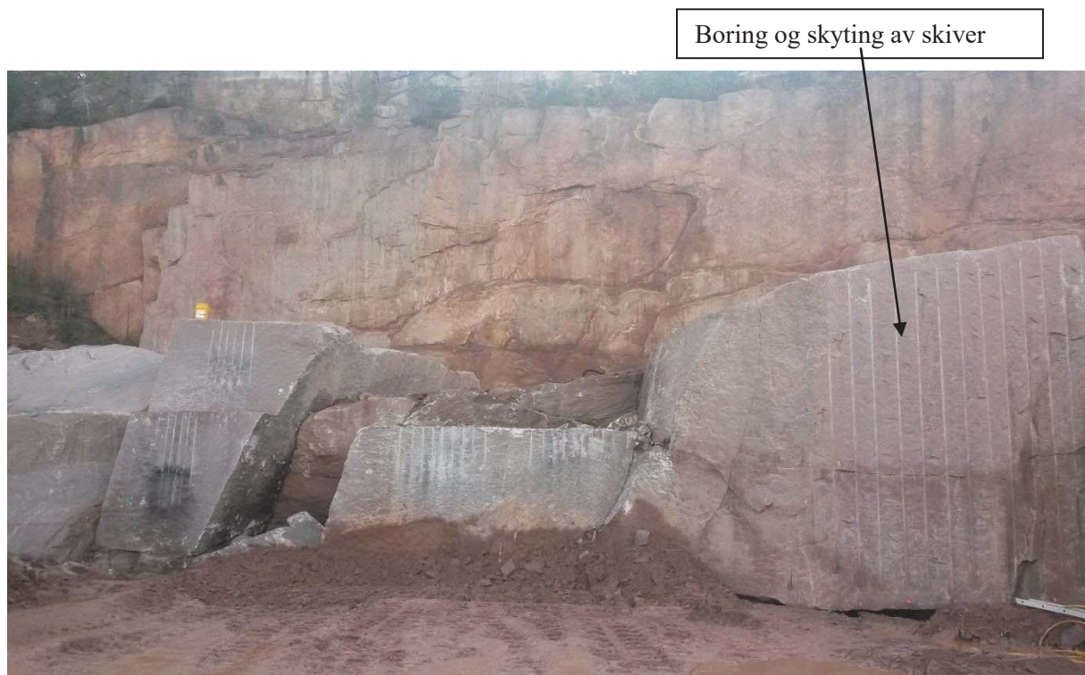
Figur 5. Når fjellet pallen er hel brytes det skiver.
