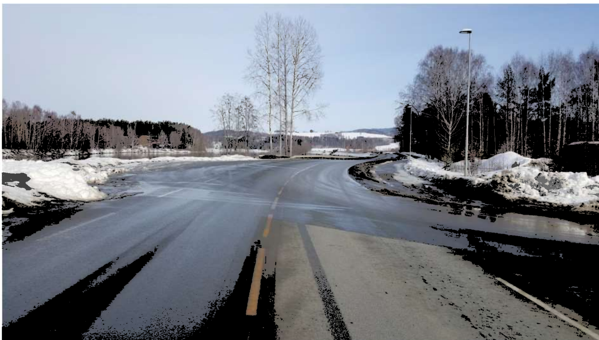
Figur 21 Fv 2854 ved innkjøringen til anlegget
