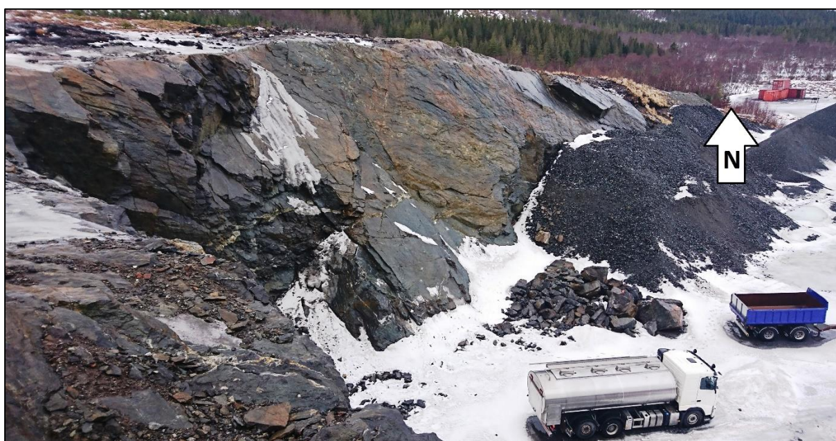
Figur 2 Vestveggen. Midt i bildet ser vi sleppen som berget har løsnet mot. Til venstre for dette har sprengningen revet løs på tvers av sleppen.
