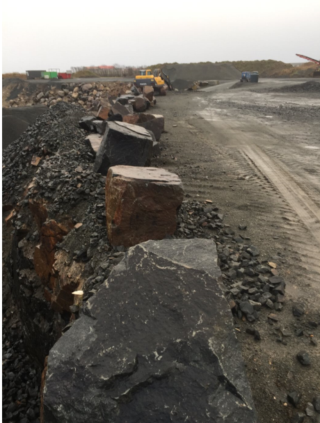
Bilde 5 Viser steinblokker plassert ved masseuttakets grop
