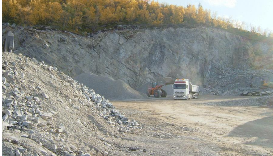
Bilde som viser oppsprekningen i bruddet. Bildet tatt fra nord mot syd i bruddet.
