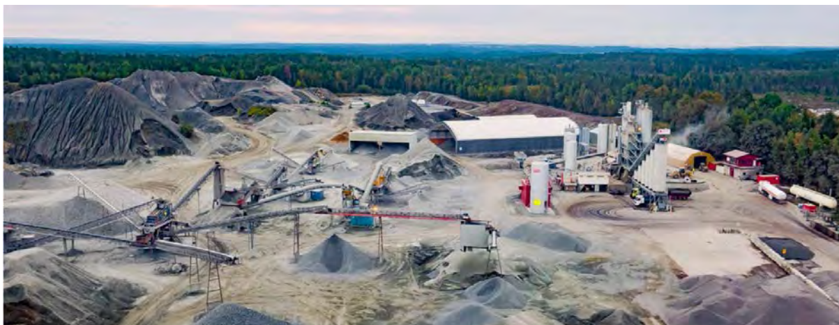
Knuseverk og asfaltstasjon (Veidekke AS)
