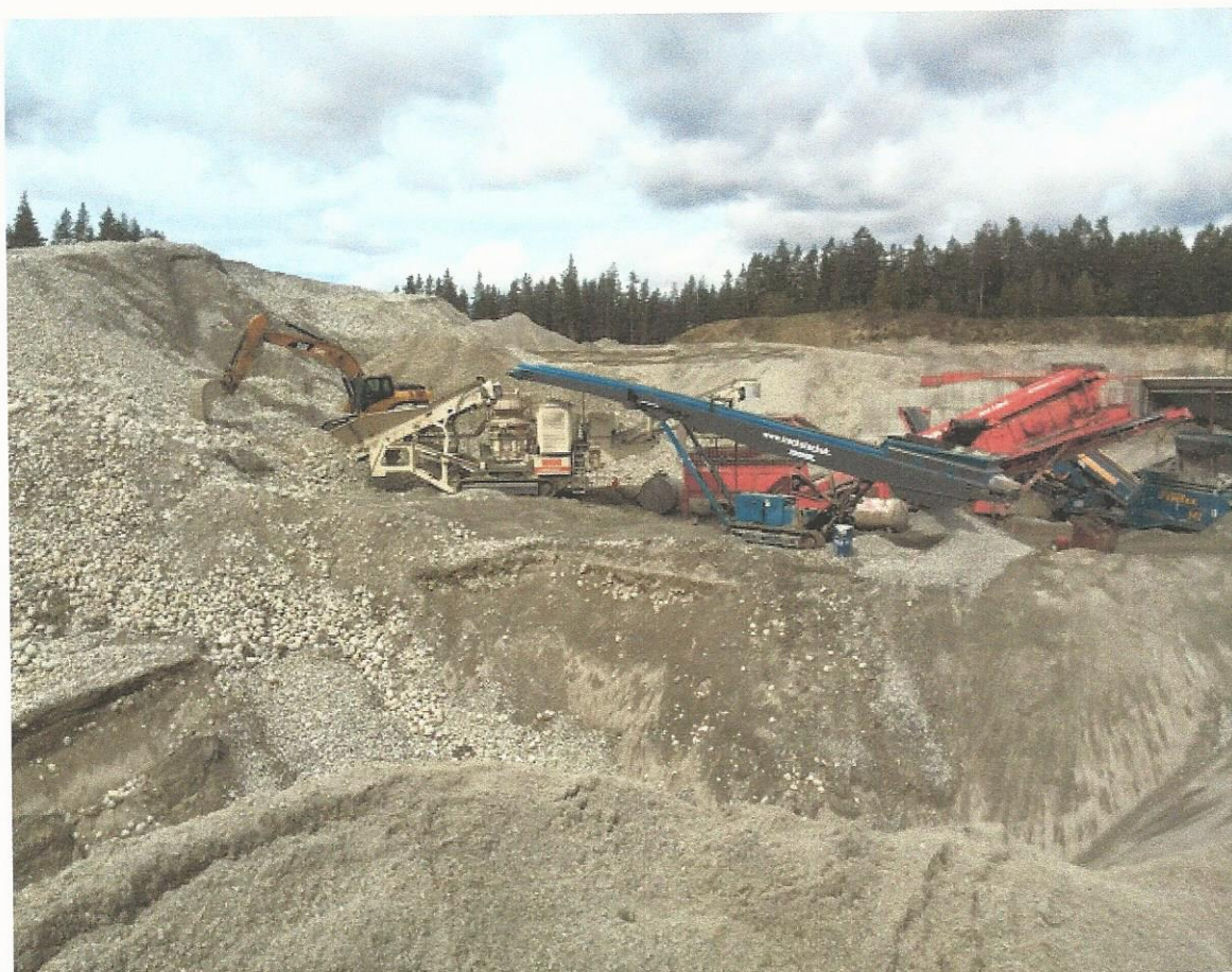
Anleggsområdet med knuser og sikter
