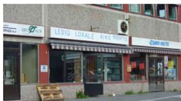
Lyskasseskilt har en uheldig visuell virkning og vil ikke lenger bli godkjent. Både størrelse og utforming gjør at skiltene er skjemmende både i seg selv og i forhold til omgivelsene.
