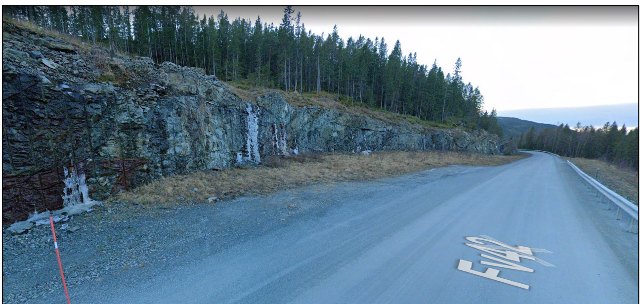
Figur 3 Utsprengt nisje langs veien hvor etappe 1 av steinuttaket skal starte. Foto Google streetview desember 2020 sett vestover
