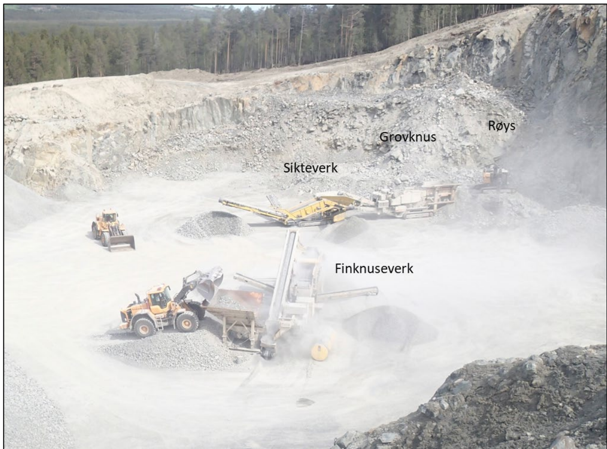
Figur 5 Typisk oppsett av maskiner under produksjon. Foto 30.05.16 Pro Invenia
