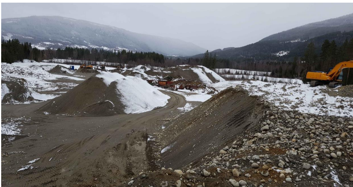
Bilde 1: Søre Risteigen masseuttak, etappe 1. Lagring av ferdige masser og skråninger på 33 grader.
