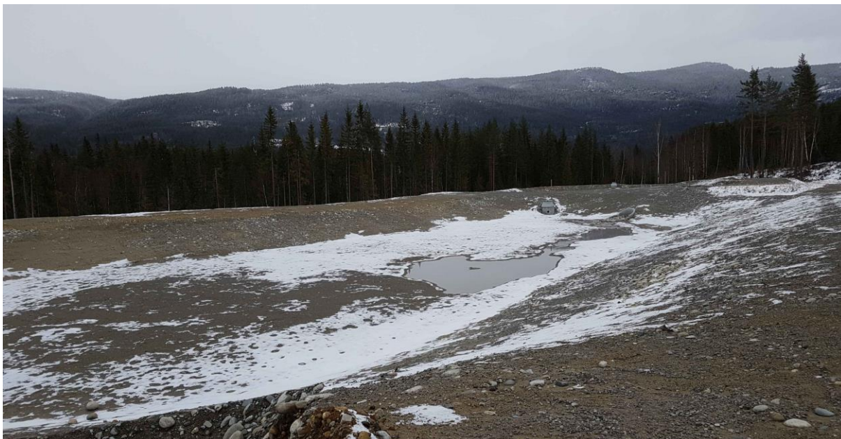
Bilde 3: Jordrenseanlegg Søre Risteigen (laguner), etablert etter avslutning av masseuttakets etappe 2.
