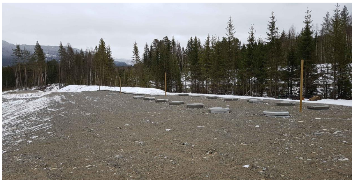
Bilde 2: Jordrenseanlegg Søre Risteign, etablert etter avslutning av masseuttakets etappe 2.
