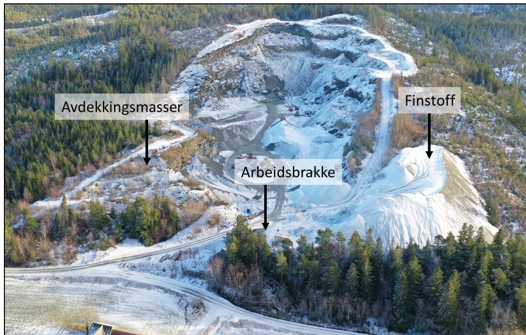
Figur 6 Dronebilde 19.02.2020 som viser hva som må ryddes ved avslutning
