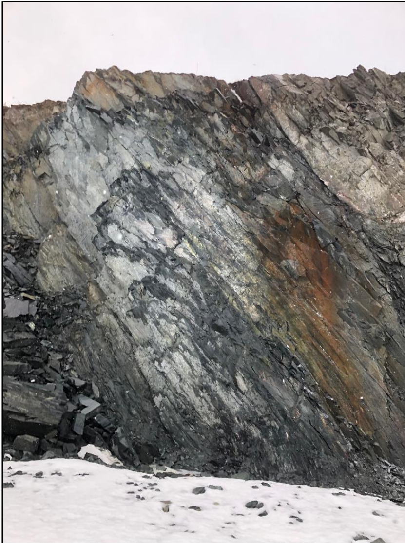
Bilde 6. Utsnitt av «fersk» sprengt flate. Fjellet er mørkt og oppsprukket.
