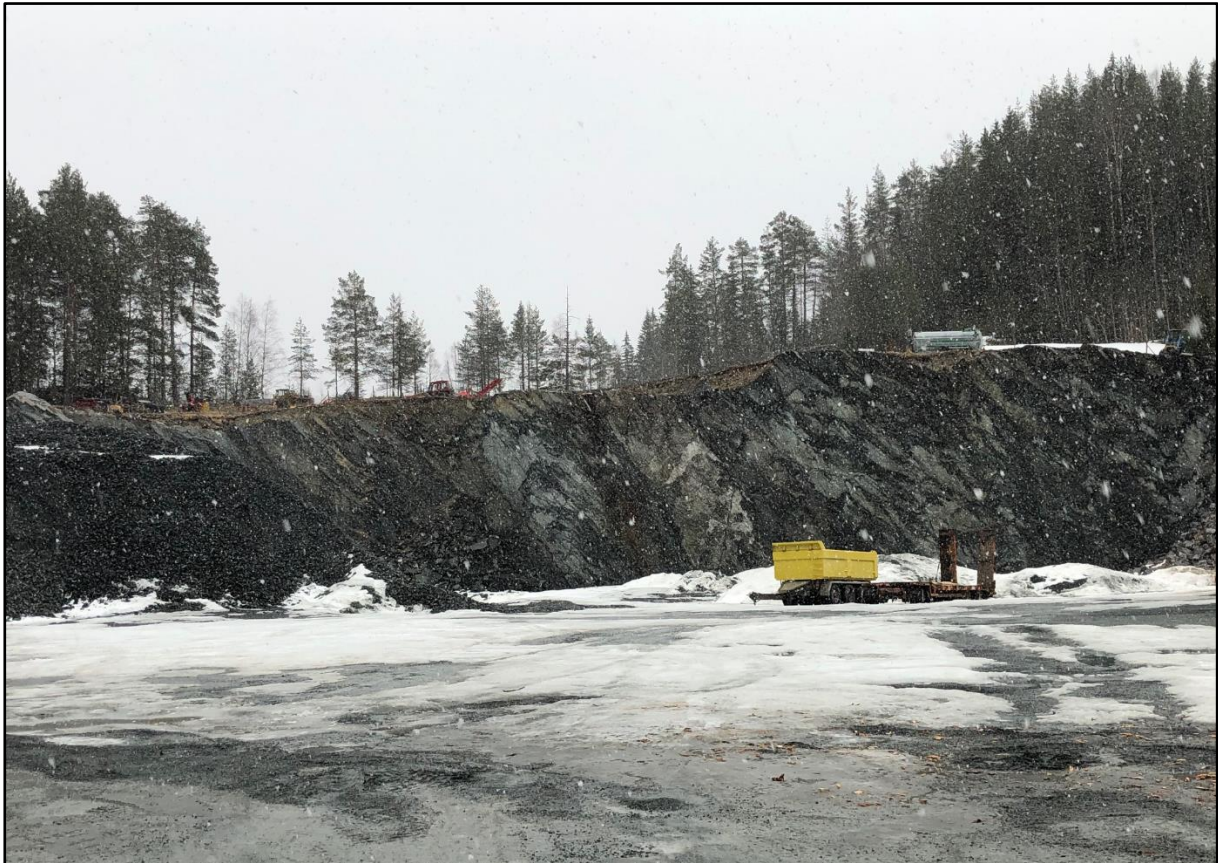
Bilde 8. Uttaket sett med sørøst. Det ses at mengden av overmasser er beskjeden.
