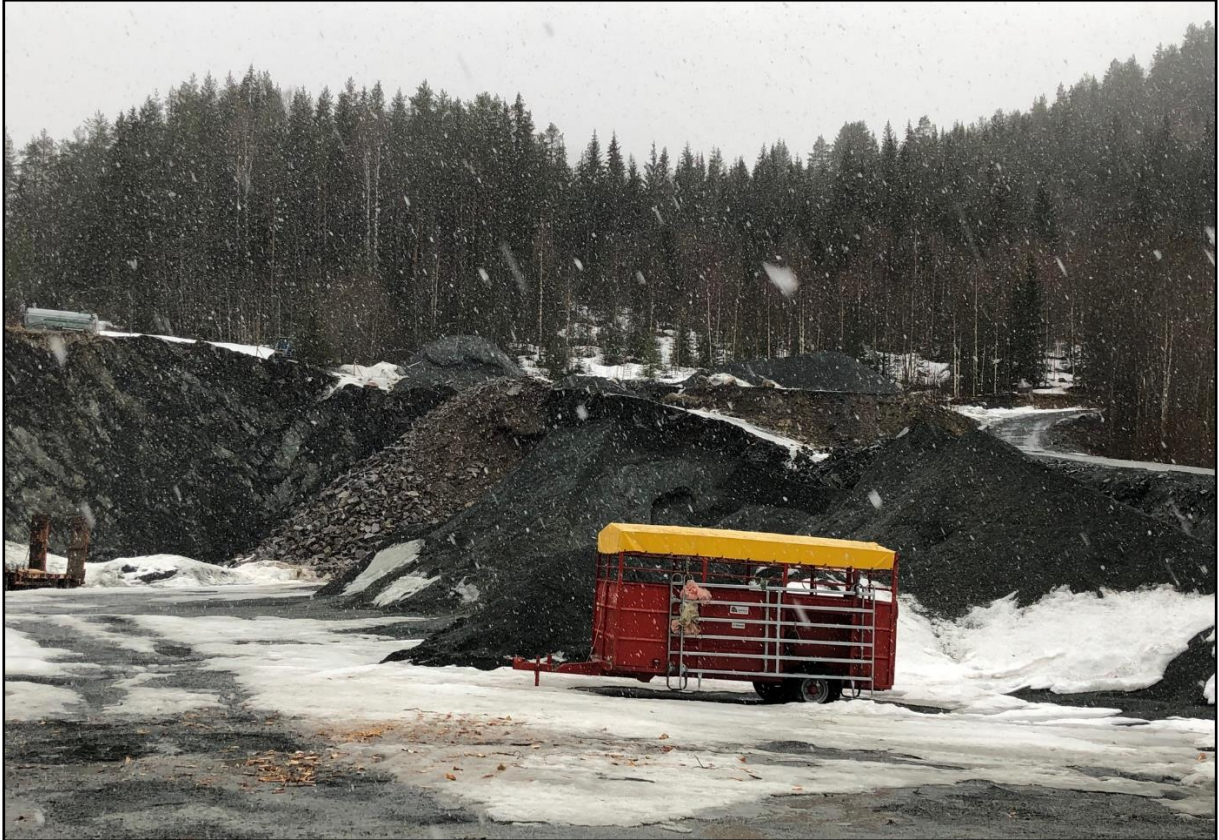
Bilde 7. Uttaket fotografert inne fra bunnivået og imot sør. Vegen inn ses til høyre på bildet.
