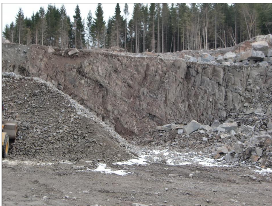
Figur 10 viser stoffen mot øst, med brattere sprekkdannelse/sprekkorientering, enn fjellet lengre mot nordvest. Bilde tatt i 2019.
