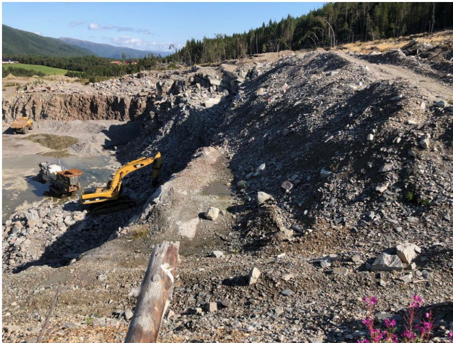
Figur 5. Bildet viser deler av de betydelige mengder løsmasse som så langt er dradd til sides, fra topp fjell.
