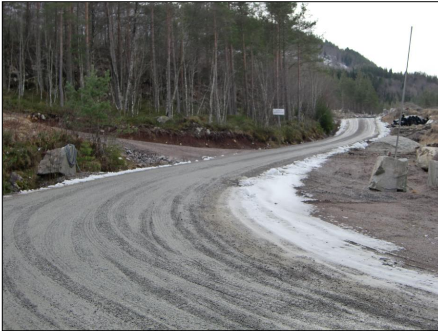
Figur 6. Bildet viser atkomstvegen inn til steinbruddet, med bom og skilting.
