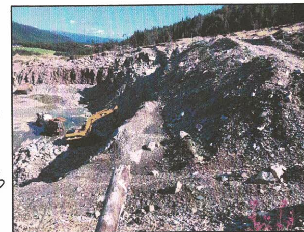
Bildet er tatt fra øst, mot vest, av uttaket i etappe 1, pr. august 2021. Bildet viser at det er betydelige mengder løsmasser over fast fjell. Massene vil bli nyttet til refylling av bruddområdet.
