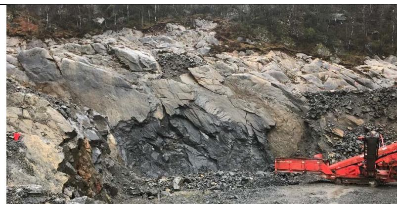
Partiet vist på foto 2 tatt mot vest. Fotoet viser at utsprengt skjæringsvegg underkutter det markerte sprekkesettet som har orientering omtrent parallelt med skjæringsveggen.
