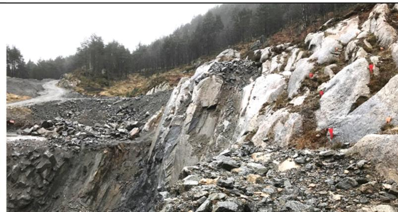
Bakvegg i eksisterende brudd med orientering N-S er omtrent parallelt med det dominerende sprekkesettet i berggrunnen (sprekkesett 1 - strøk NNV-SSØ til N-S og fall 75-80° Ø).
