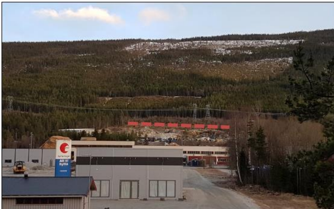
Figur 10: Bildet viser planområdet sett fra RV. 7 øst for avkjøringen. Stiplet linje viser omtrentlig topp skjæring. Dette er det eneste punktet en ser området godt fra riksvegen. Tettere på er det bygninger og vegetasjon som kommer i front, bortsett fra helt opp ved området.
