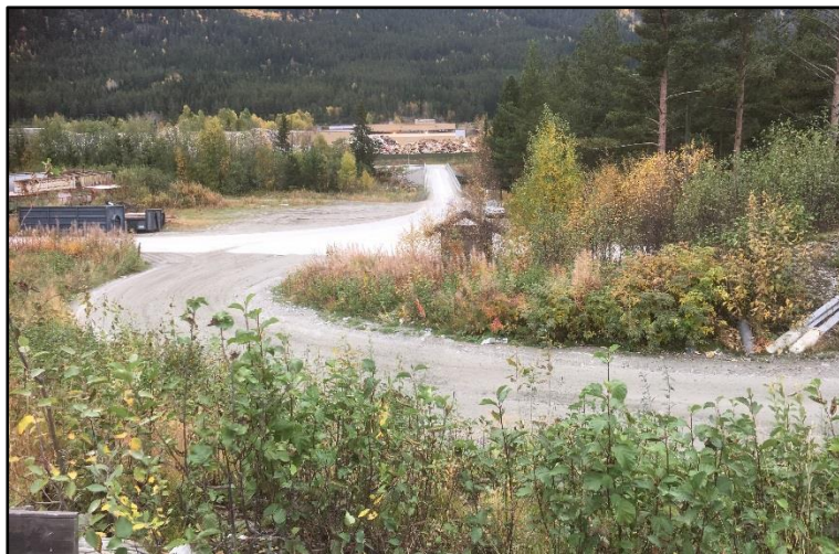
Figur 9. Veggen inn til Felt 2. Bru over Holselva ses i bakgrunnen.
