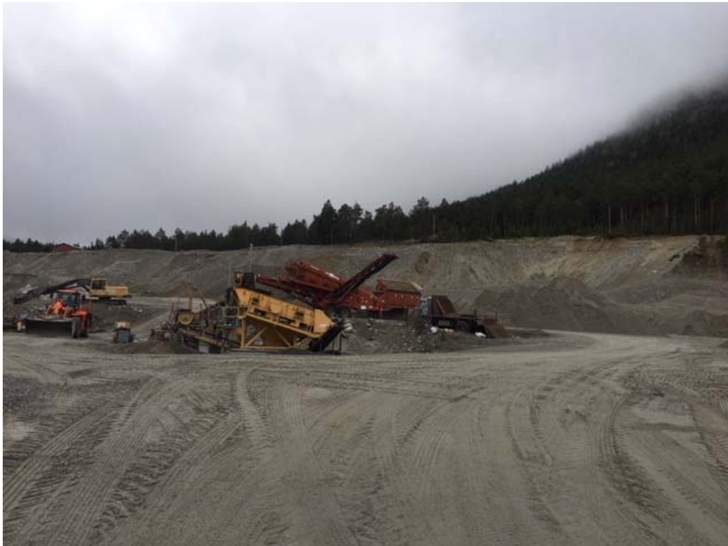
Bilde 2: viser pukkverk ved graven
