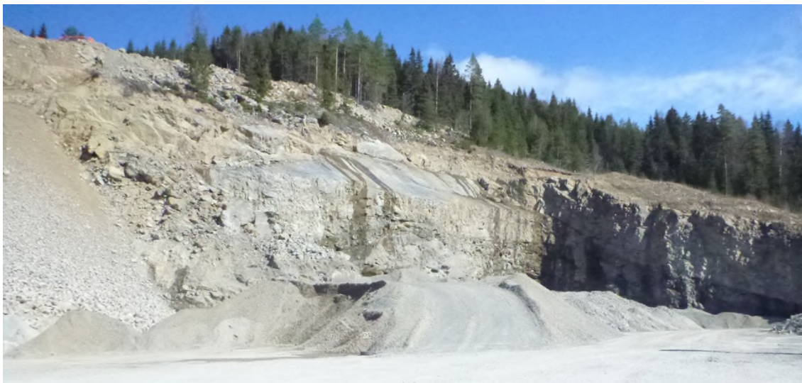
Figur 9. Bildet viser den nordlige bruddveggen med sleppeplanet. Bildet er tatt av Norconsult 22.06.2016.
