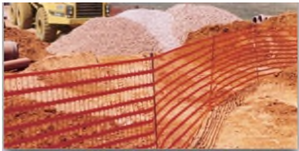
Figur 13. Eksempel på midlertidig gjerde. Høyde 1 meter.
