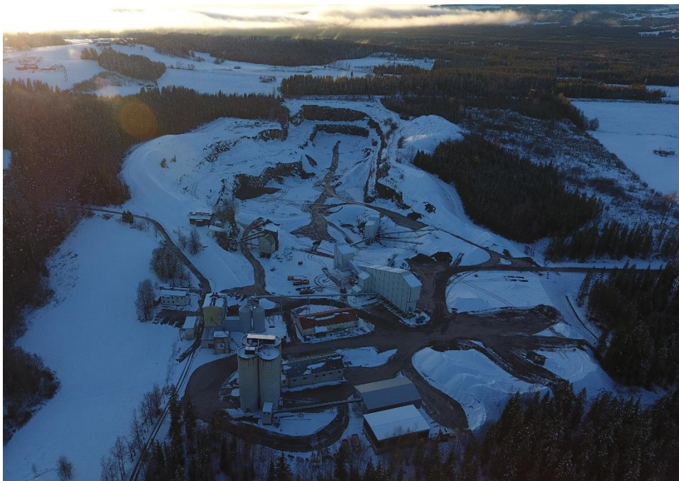
Figur 1.1. Oversiktsbilde over industrianlegget og dagbruddet på Bøverbru.
