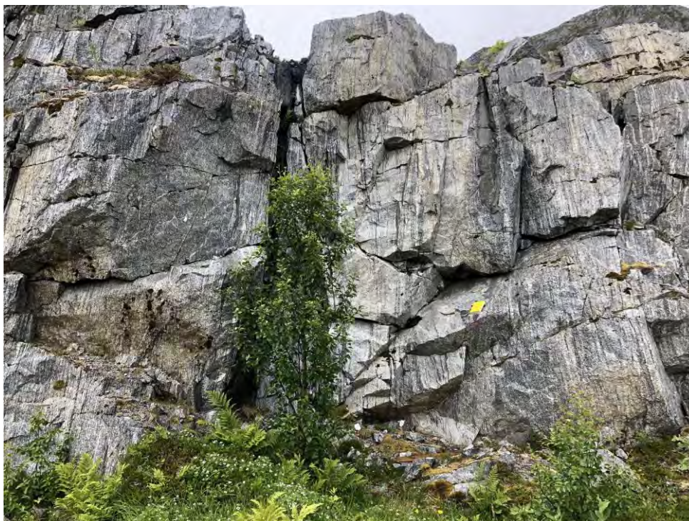
Figur 2. Bergskjæring i eksisterende brudd ved Stihågen, sett ca. mot øst.
