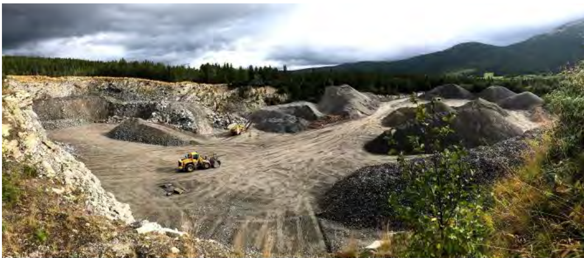
Oversiktsbilde maskinoppstilling og masselager
