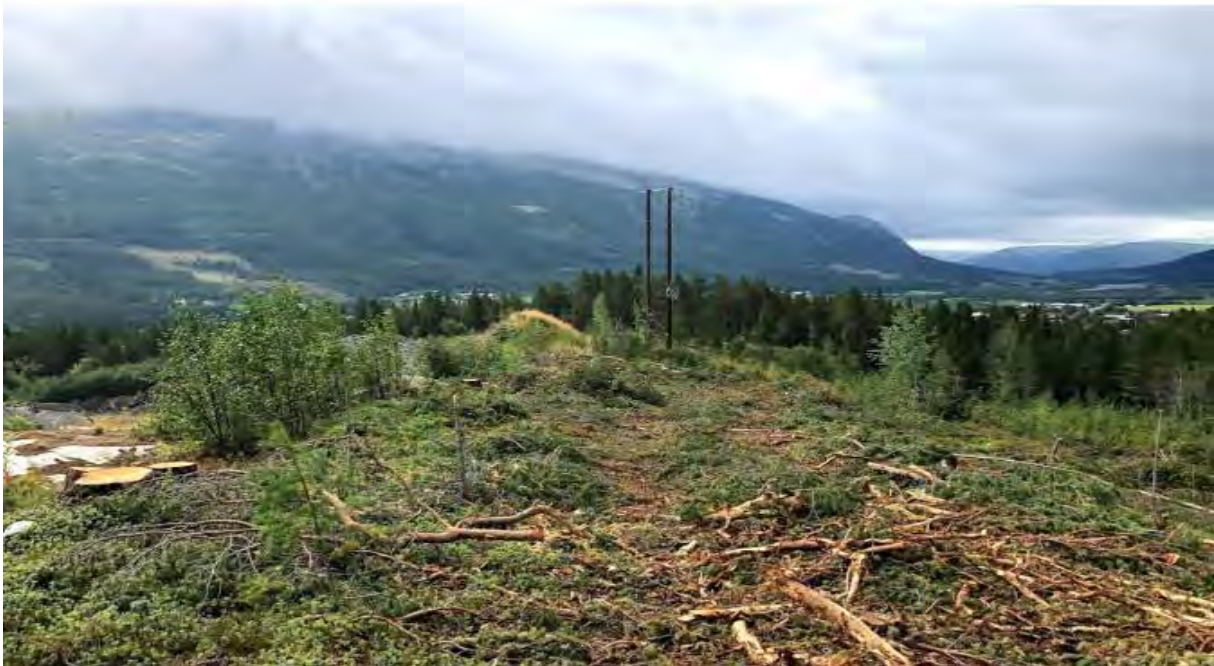
Bilde av høyspentmast i uttaksområdet som må flyttes
