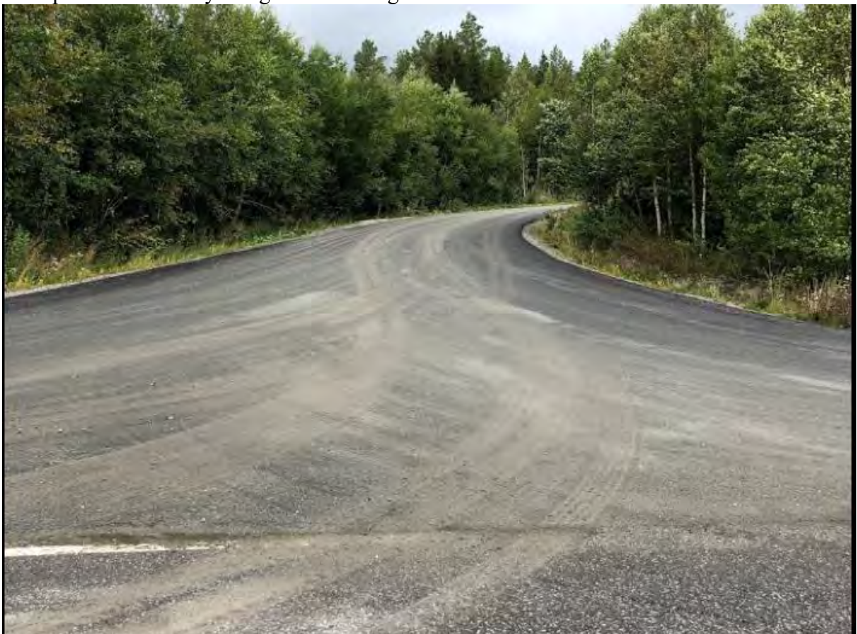
Bilde av asfaltert atkomstveg ved avkjørsel fylkesveg 2232.
