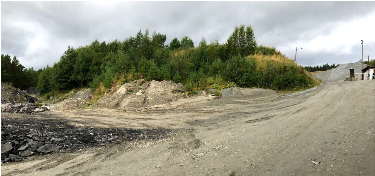
Bilde av vegetasjonsskjermen mot nord og viser massene som skjerner fjelltaket.
