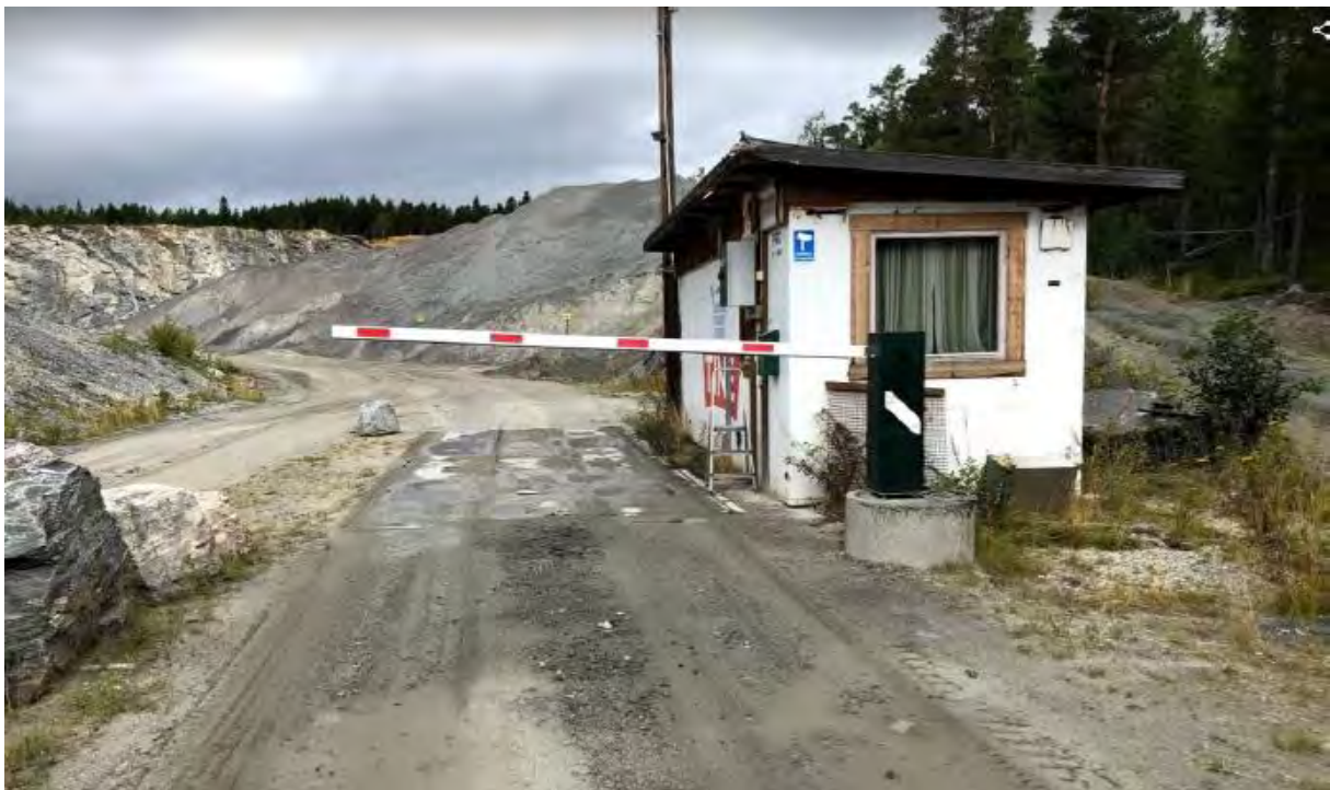
Bilde av inn-utkjøring med bom og vekt.
