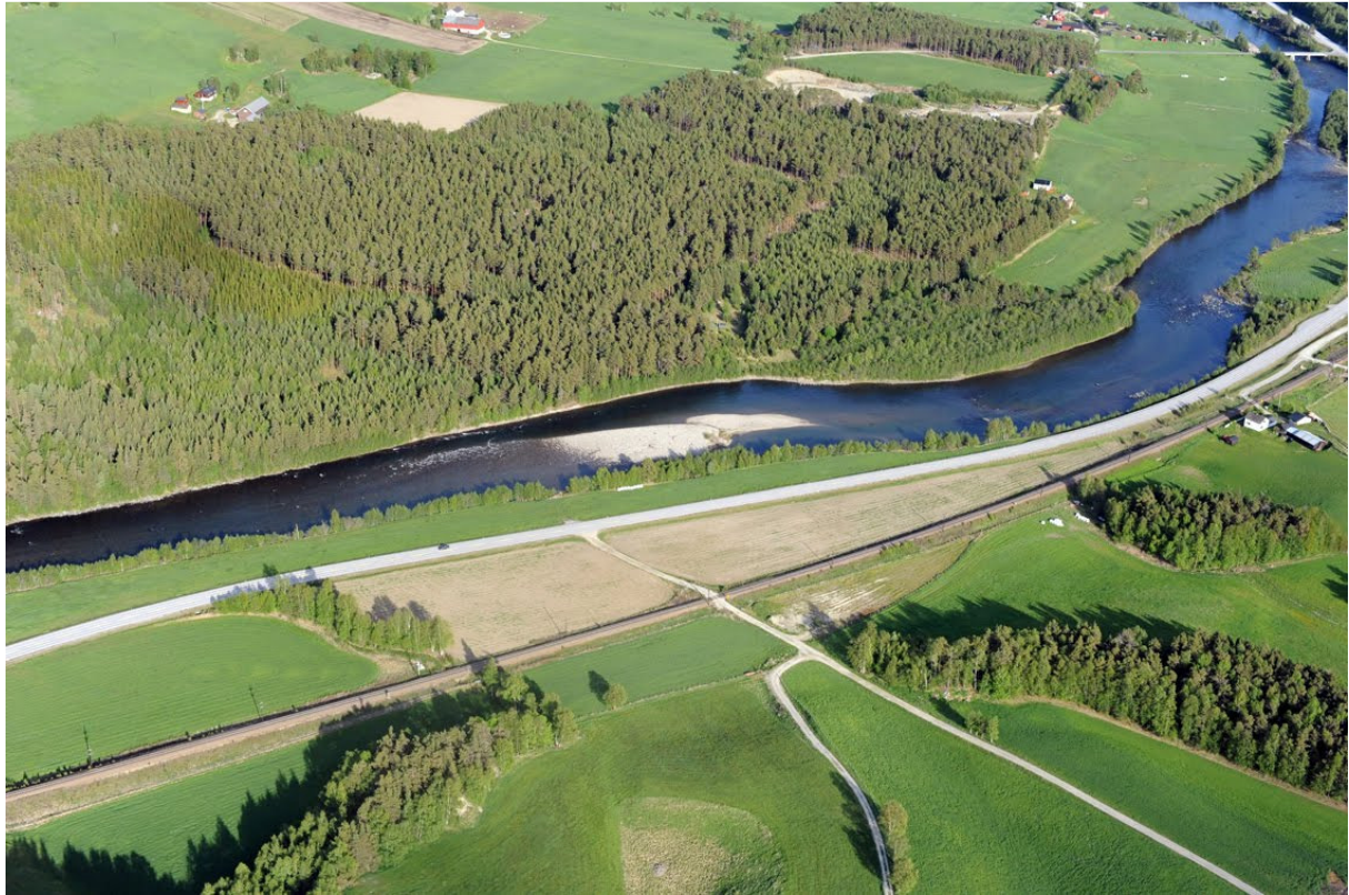
Figur 4. Bilde er tatt mot sørøst i 2010. E6 og Lågen vises i forgrunn mens uttaksområde er beliggende i skogen på motsatt side av Lågen omtrent der ungsbogen er synlig i vestre del av bildet. Kilde: Panoramio.com
