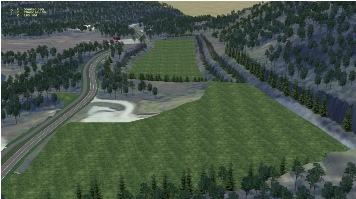
Figur 5 Illustrert utvikling av planområdet. Fase 3. Uttak ned til kote 70. Område sett fra nord.
