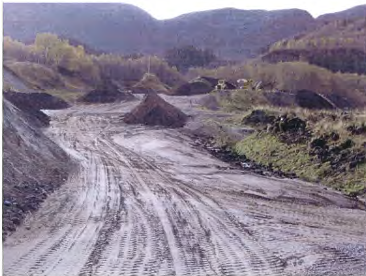
Bildet viser anlegget for produksjon av matjord, syd i området.
