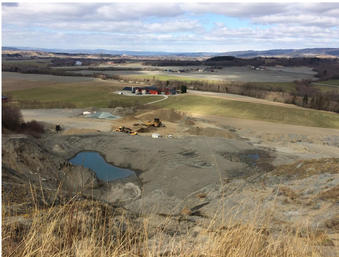
Figur 1 – Uttaket sett fra toppen, i retning gården Melby
