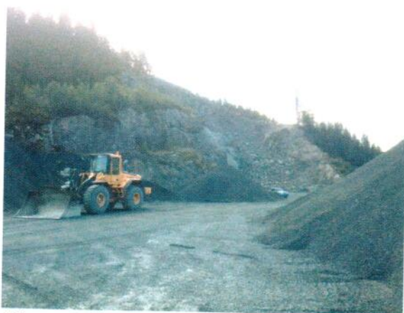
På grunnflatenivå inn mot bruddet
