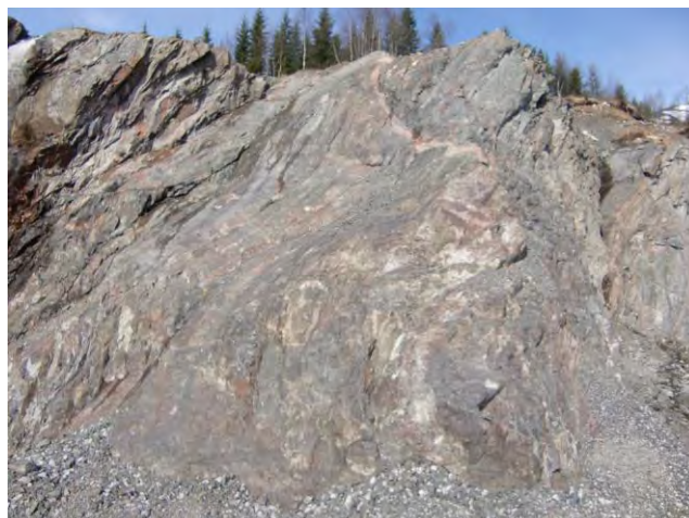
Figur 11. Parti videre nordover i vestveggen. Her er sprekksonene avrundet både horisontalt og vertikalt. På toppen av vestveggen er det minimalt med løsmasser.
