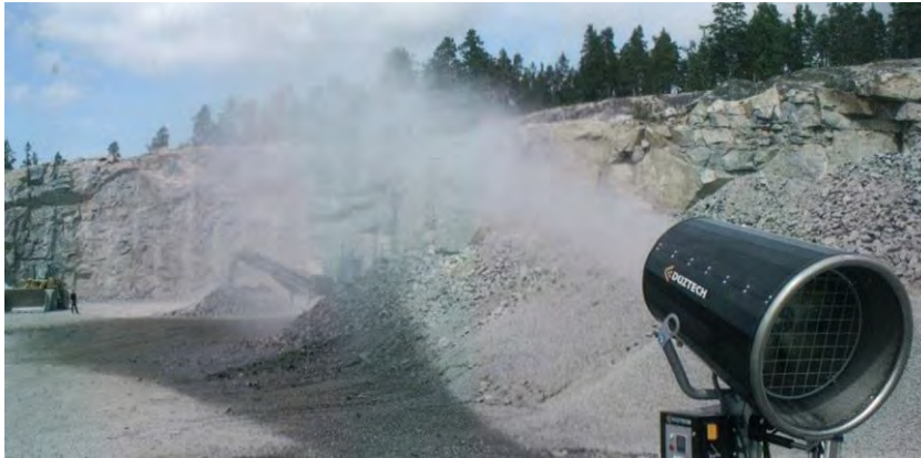
Figur 19. Vannstøver-kanon i aksjon over knuseanlegg
