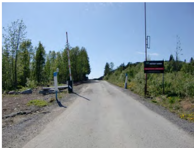
Figur 3. Innkjøring til massetaket, med bom og skilting.
