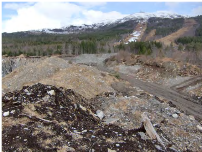
Figur 16. Bilde viser område for etappe 2 og 3. Betydelige mengder løsmasse er lagret her.
